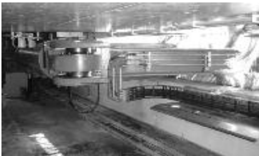
In de kelder zijn de deuren.
