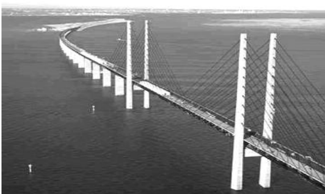
De brug die Joretsma graag zou willen..
